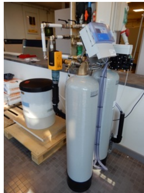
Figura 1. Impianto di addolcimento
